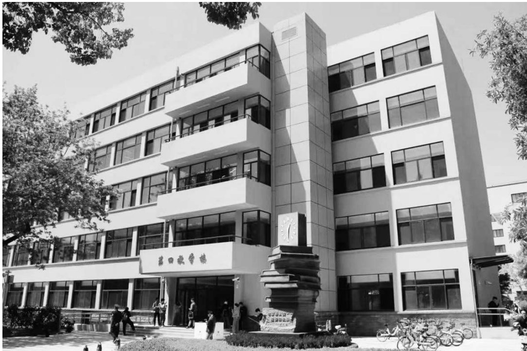
■ 基本完成修缮后的第四教学楼外观
